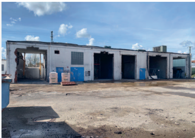
Werkhallen im Umbau
