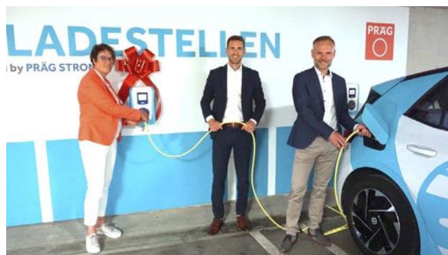
In der Tiefgarage „Neue Schranne“ wurden im Juni 2022 drei E-Ladestationen mit einer Leistung von je 22 KW in Betrieb genommen.
